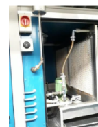
HLK Anlage hinter Anlageschalter
