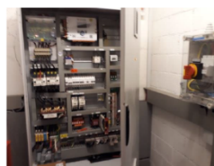
Aufzugsanlage hinter Anlageschalter
