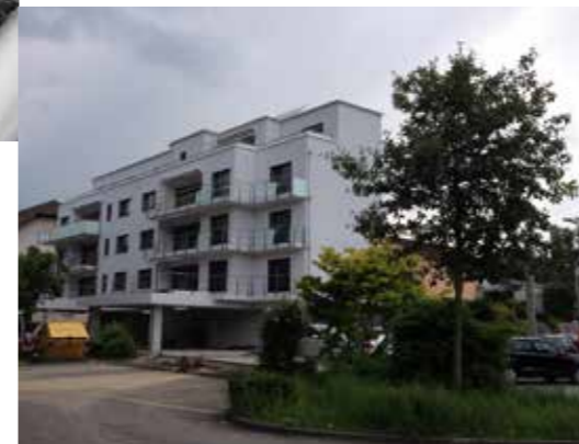
Beim Neubau eines Mehrfamilienhauses in Ebikon wurde auf Solarthermie für Brauchwasser gesetzt. Damit erfüllte man die Vorschriften für Neubauten, die höchstens 80 Prozent nicht erneuerbare Energien erlauben.
