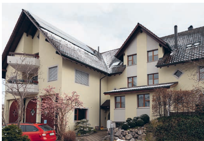
Der Hauseingang des Mehrfamilienhauses mit der auf dem Dach installierten PV-Anlage
